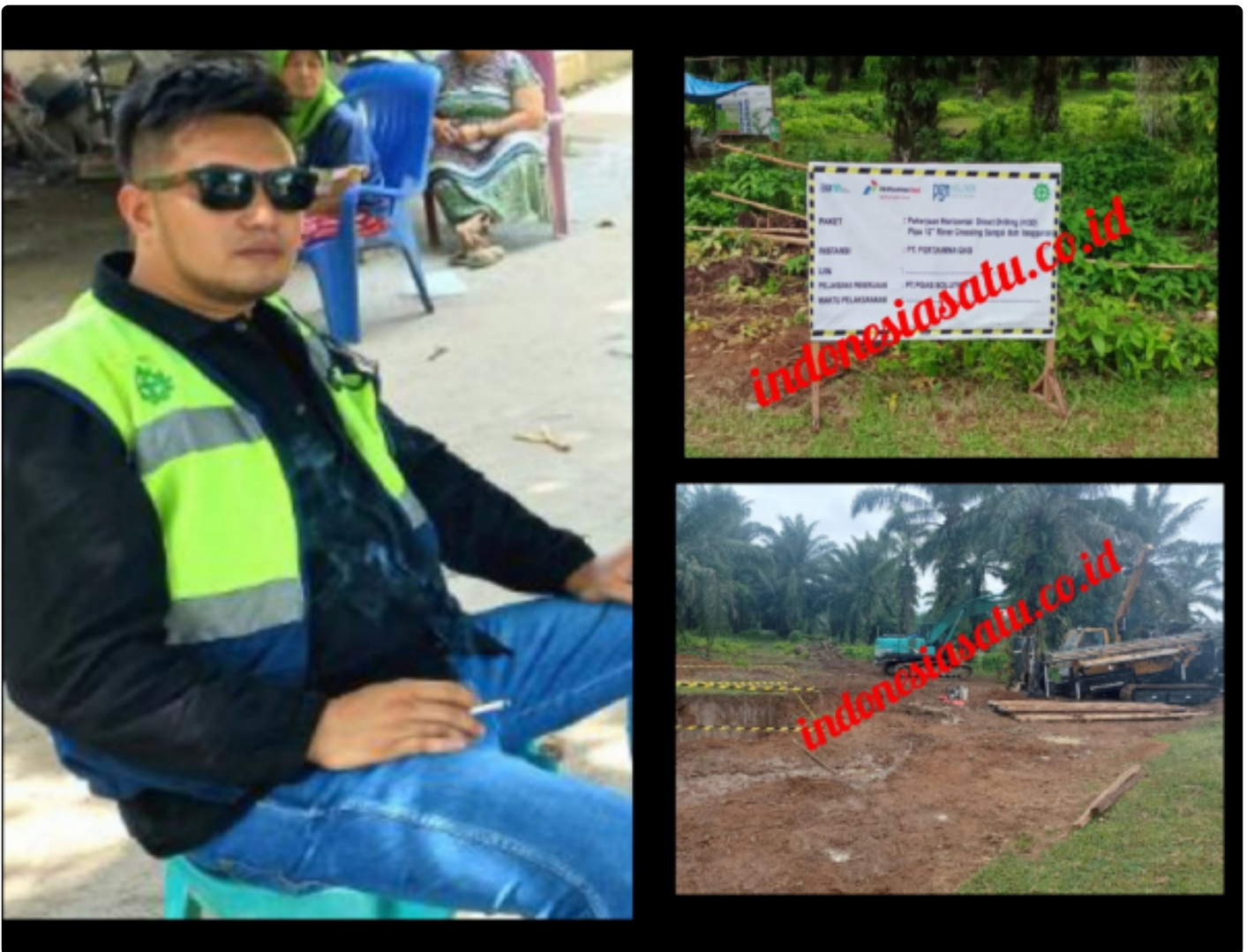
Pengeboran Jalur Pipa Milik PT Pertamina Gas di Sungai Bah Tongguran Dikerjakan PT PGAS Solution
